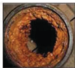
3 miesiące po instalacji
