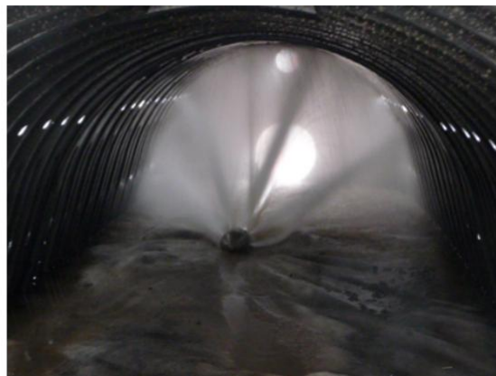
Zdjęcie 15: Czyszczenie wysokim ciśnieniem
