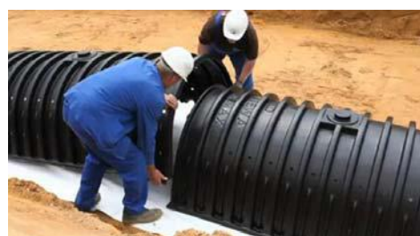
Zdjęcie 9: Łączenie tuneli.
