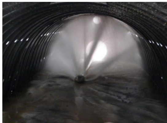
Zdjęcie 4: Głowica płucząca w trakcie czyszczenia układu.
