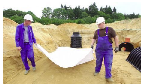
Zdjęcie 7: Geotkanina na dnie wykopu.
