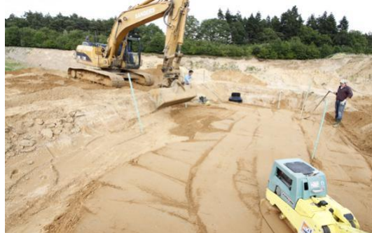
Zdjęcie 12: Zagęszczanie gruntu pomiędzy tunelami
