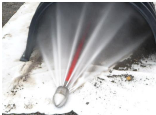
Zdjęcie 3: Głowica płucząca ze strumieniami wstecznymi czyszczenia układu.
