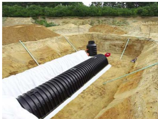
Zdjęcie 10: Przyrywanie rzędów tuneli geowłókniną
