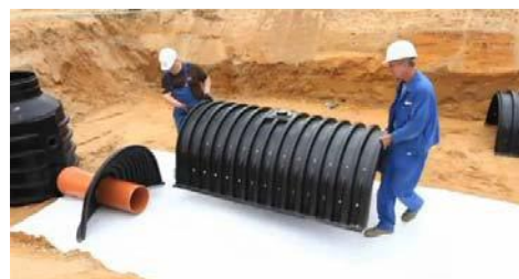
Zdjęcie 8: Wykonanie wlotu/
