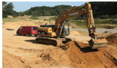
Zdjęcie 5: Wykonywanie wykopu.
