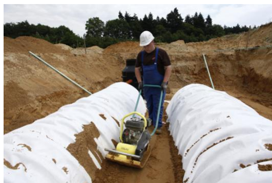
Zdjęcie 12: Zagęszczanie gruntu pomiędzy tunelami
