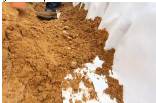
Zdjęcie 10: Przyrywanie rzędów tuneli geowłókniną
