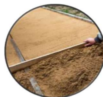
Wypoziomowana podsypka piaskowa
