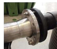
Przykręcanie kołnierza
