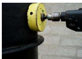
Wiercenie otworu wejściowego z odpowiednim wiertłem rdzeniowym i wiertarka
