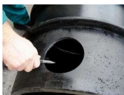
Czyszczenie krawędzi otworu
