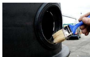
Wkładanie i smarowanie uszczelki wlotowej i rur PCV
