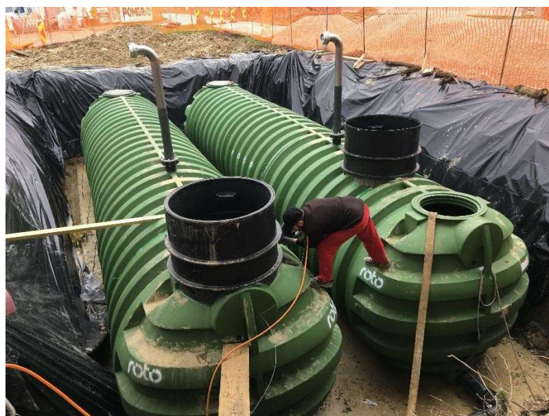
Przykład: PS Lopata - instalacja 80 m3 zbiorników ppoz na terenie o wysokim poziomie wód gruntowych
