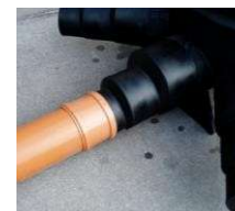
Połączenie rurą PCV
