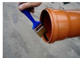
Smarowanie rur PCV i uszczelki
