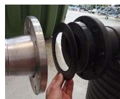
Wkładanie kołnierza z uszczelką
