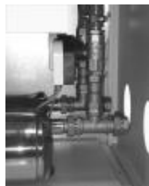
Rys. 2 Przyłącza rur ssących
