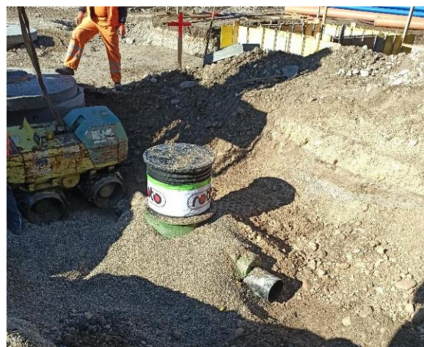
Fot. 4. Zbiornik obsypany żwirem 4/16 mm
