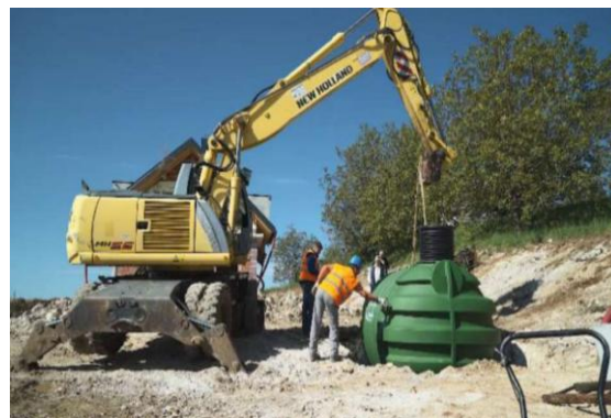
Fot. 3. Montaż zbiornika
