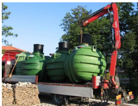
Fot. 1. Prawidłowy transport i rozładunek zbiorników
