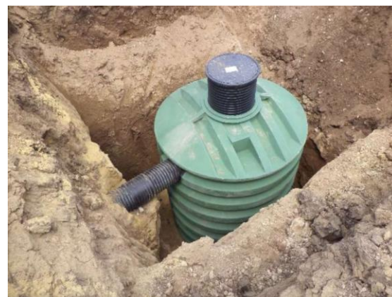
Fot. 4. Posadowiony zbiornik
