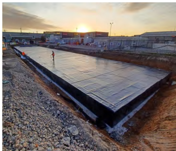
Instalacja układu retencyjnego
