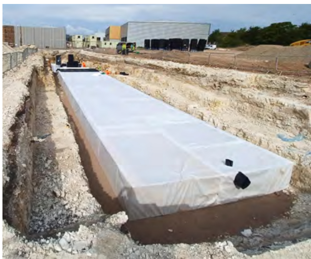
Instalacja układu rozsączającego
