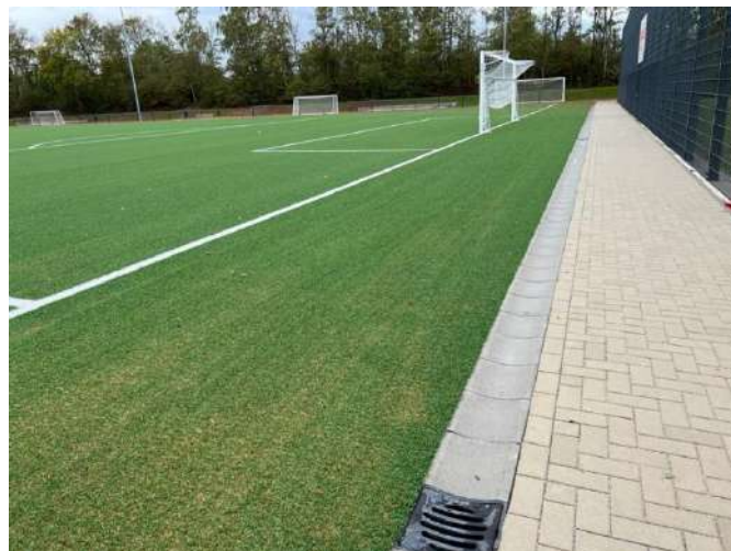
Rys. 2. Betonowe rynny zbierające i transportujące wody opadowe
