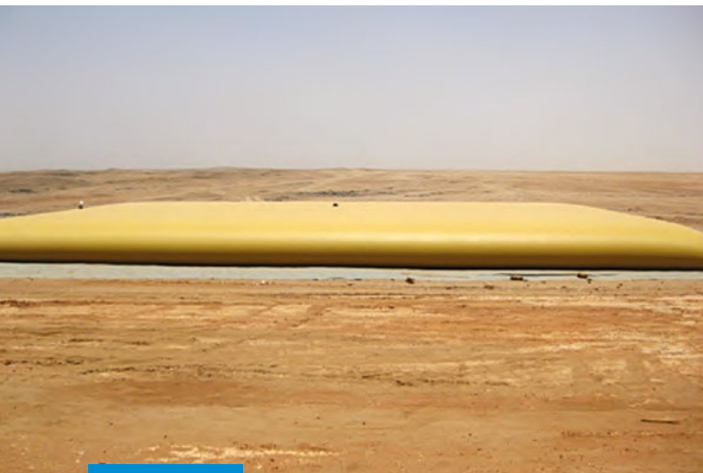
Zbiornik wody pitnej na Saharze
