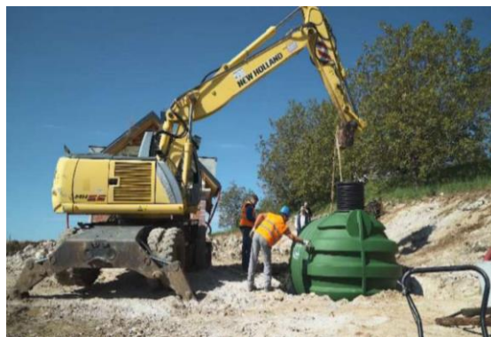
Fot. 3. Montaż zbiornika
