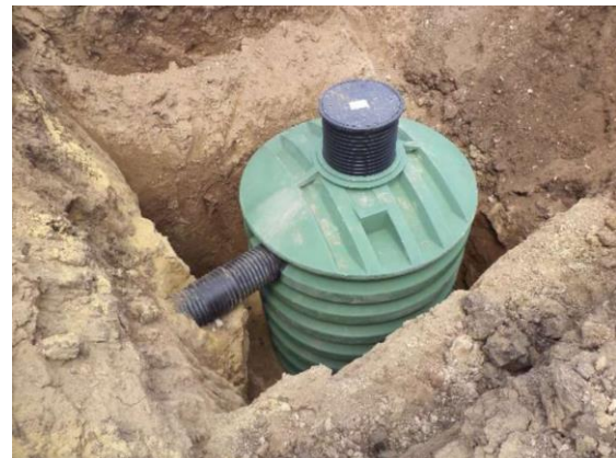
Fot. 4. Zainstalowany zbiornik
