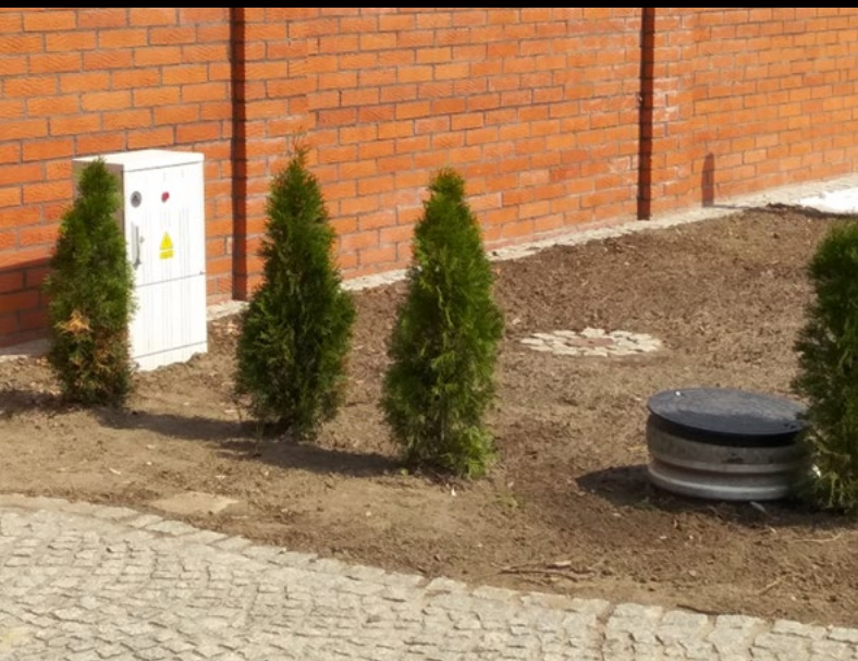
Widok zbiornika i skrzynki technicznej
