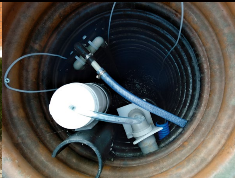
Wnętrze zbiornika od strony terenu
