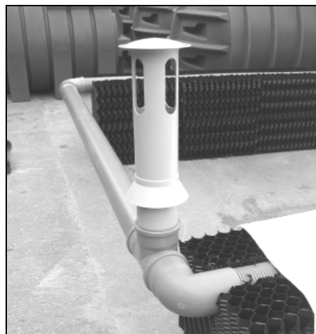
Połączenie wywiewki kanalizacyjnej z dwoma rurami drenarskimi
