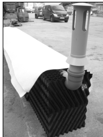
Wywiewka kanalizacyjna zamocowana na końcu zestawu skrzynek rozsączających
