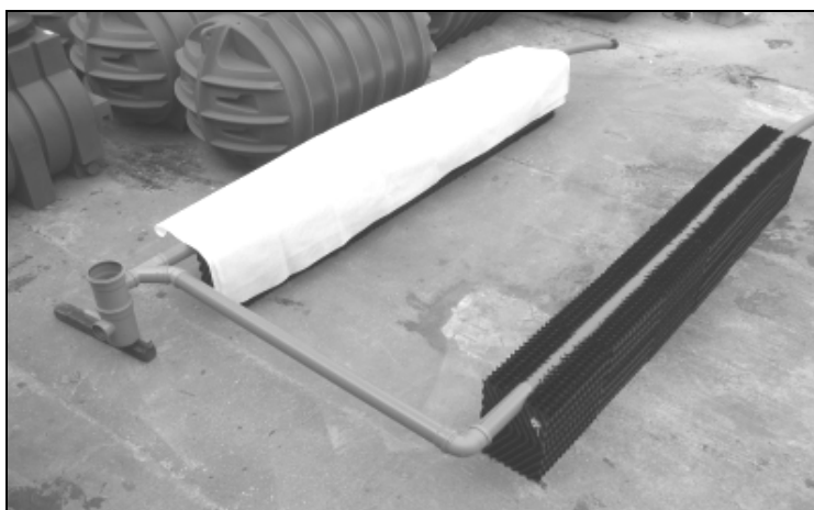
Przyłączenie do studzienki rewizyjnej drugiego rzędu skrzynek KLAR BOX.
